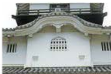
軒唐破風と火燧窓 破風とは、軒の三角形部分をさし、掛川城天守閣に用いられているものは寺社建築に起源をもち、唐破風と呼ばれます。火燧窓は、鎌倉時代以降に禅宗寺院の建築に用いられた窓の型式。ともに城郭の装飾として用いられるようになりました。
